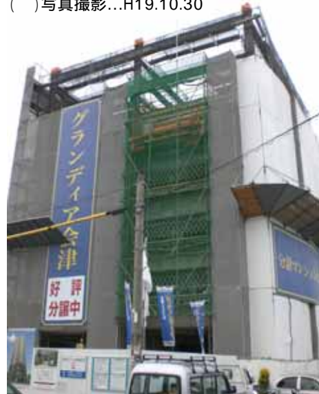
(工事状況：外観)
