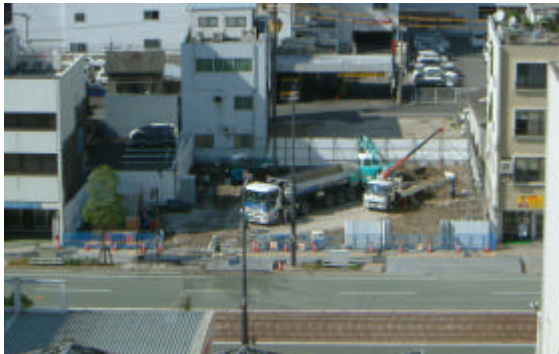
< 工事現況 9月1日 撮影 >
